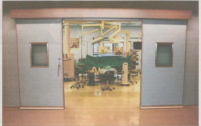
Blick in den größeren der beiden Operationssäle: Viele High-Tech-Geräte und möglichst wenig Schläuche und Kabel sollen erfolgreiche Eingriffe ermöglichen.
