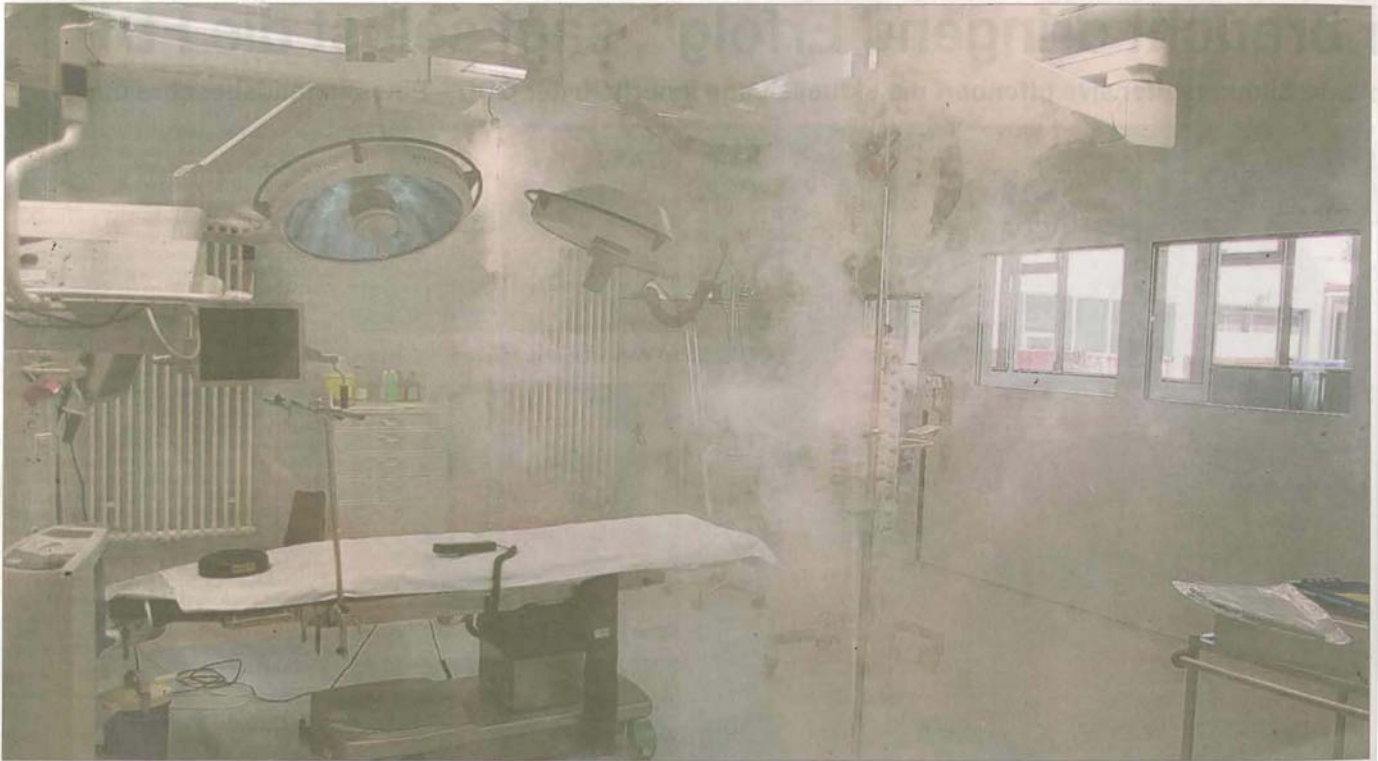
Mit Hilfe von Nebelschwaden wird das Strömungsverhalten von Luft im OP sichtbar. Das hilft den Operateuren, den Raum keimfrei zu halten
